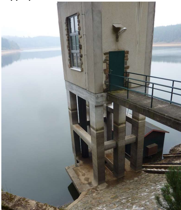
Fotografie vtokové věže (horní strojovny) při snížené hladině (úroveň pracovní plošiny 472,53 m n.m.)
